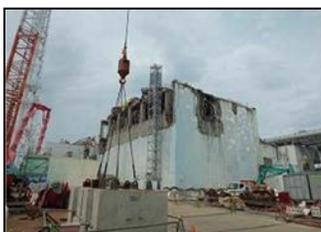
原子炉建屋ガレキ撤去作業後
