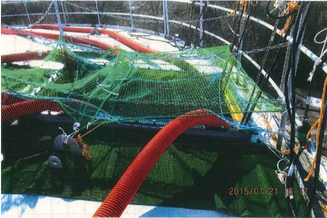
ハッチ開口部転落防止措置
