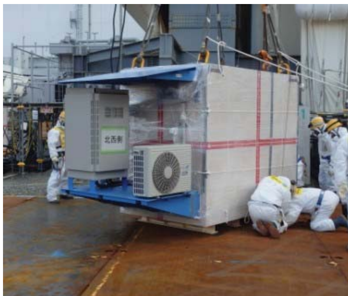
写真3 測定装置1(北西側)の設置作業
