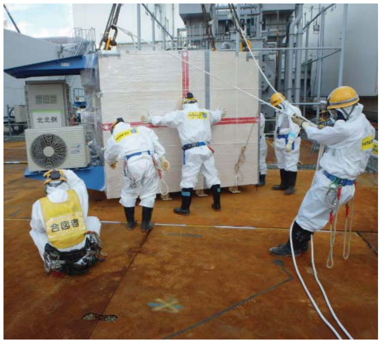
写真2 測定装置2(北側)の設置作業
