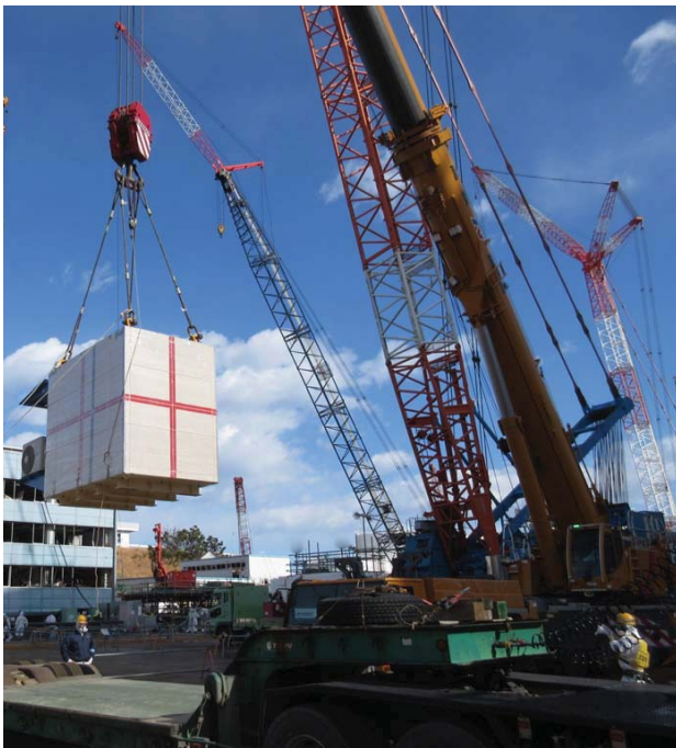
写真1 クレーンによる荷下ろし作業
