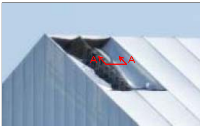
シート切断部拡大状況
