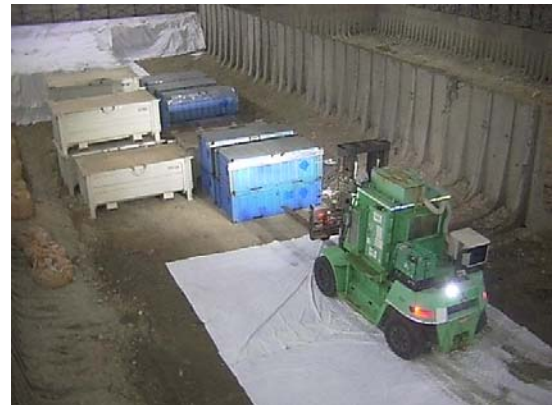
②コンテナ移動 作業状況 (H27.2.23)
