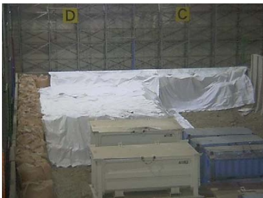
①ガレキ覆土シート養生 完了状況 (H27.2.20)
