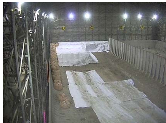
③コンテナ移動 完了状況 (H27.2.24)
