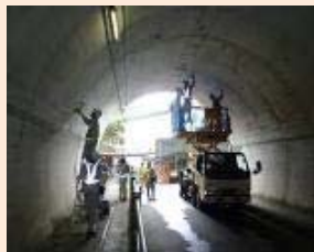
(トンネル点検)
