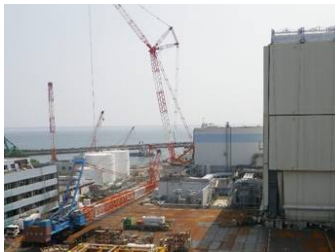
750tクローラクレーン
