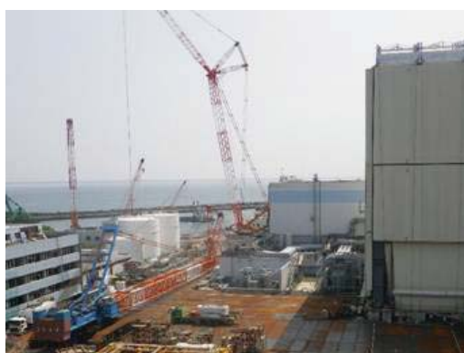
750tクローラクレーン
