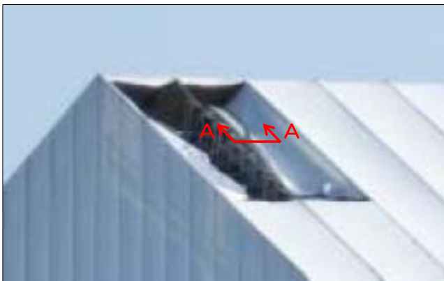
シート切断部拡大状況
