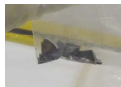
2号機コア表面塗膜 (2RB-DE-C2)
