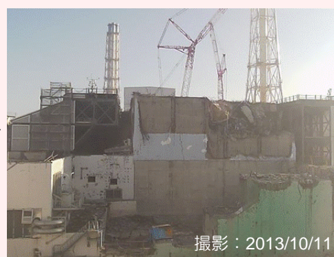
大型ガレキ撤去後
