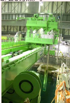
燃料取り出し状況
