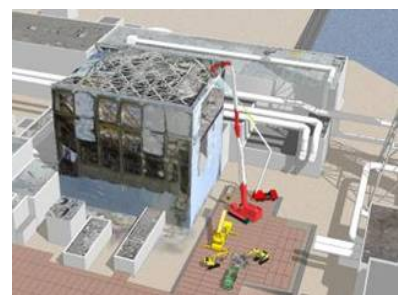
原子炉建屋上部のガレキ撤去
