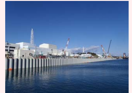
海側遮水壁工事状況
