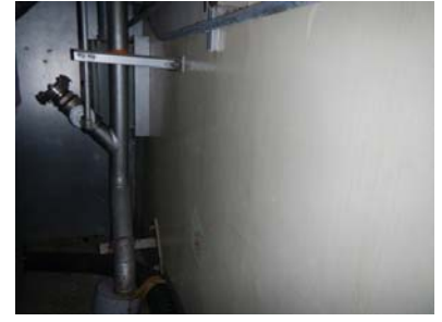
④ 西面（内壁）
