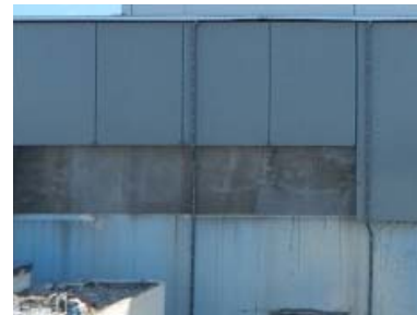
⑤ 西面（外壁）
