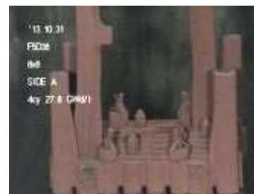
図3 上部タイプレート締結部の外観
