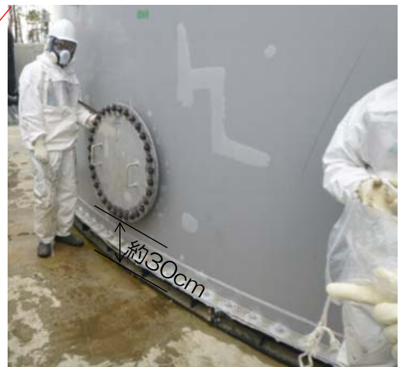
サンプルタンクC側面マンホール写真
