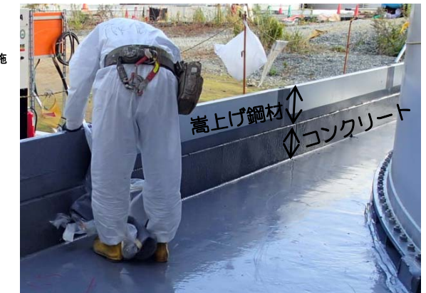
鋼製板による堰の嵩上げ実施状況
