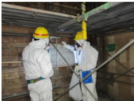
2階における使用済燃料プール底部に設置した支持構造物による補強の状況の確認の様子。(4月23日)
