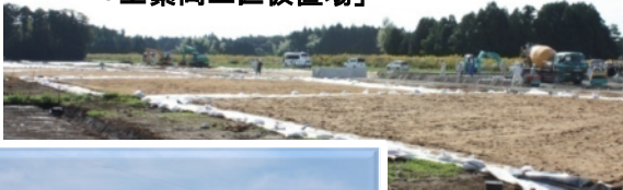
「上繁岡工区仮置き場」
