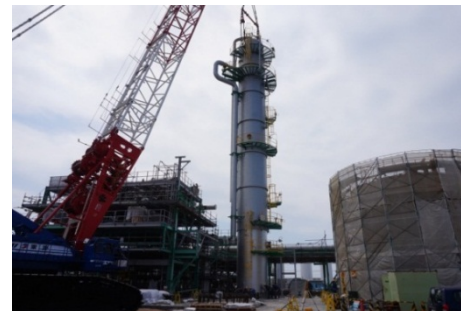
<CO2分離・回収設備の建設>
