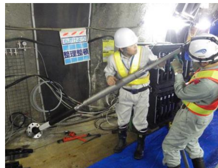
深地層の研究施設における物質移行試験作業
