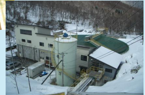
(坑廃水処理施設の例)
