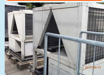
老朽化による生物遺伝資源の劣化リスク、電気保安行政の技術支援業務の停滞リスク
