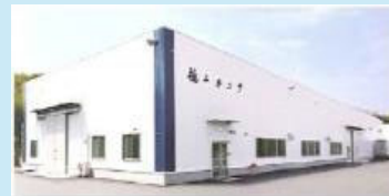
倒壊した工場・施設等の復旧支援
