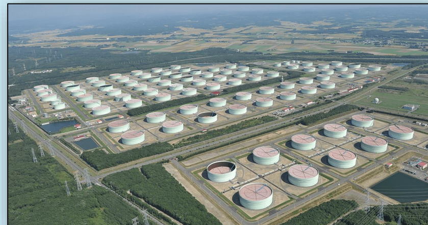
苫小牧国家石油備蓄基地（北海道）
