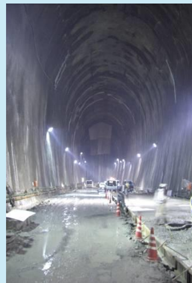
倉敷基地地下貯槽の様子 (建設時) ※2
