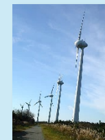
例：風力発電設備の工事計画の審査体制の見直し
