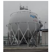
③ 陸上貯蔵用タンク
