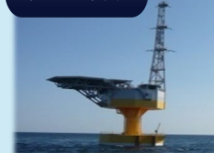
洋上サブステーション搭載 アドバンストスパー浮体 「ふくしま絆」
