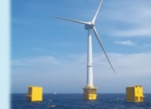
7MW油圧風車搭載 V字型セミサブ浮体 「ふくしま新風」
