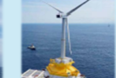
5MWダウンウインド風車搭載 アドバンストスパー浮体 「ふくしま浜風」
