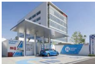
<中規模水素ステーション>
