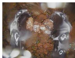
2号機格納容器の内部調査
