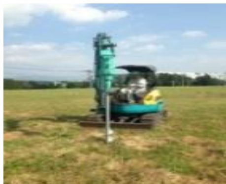
（設備設置のための調査）
