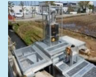
小水力発電施設
