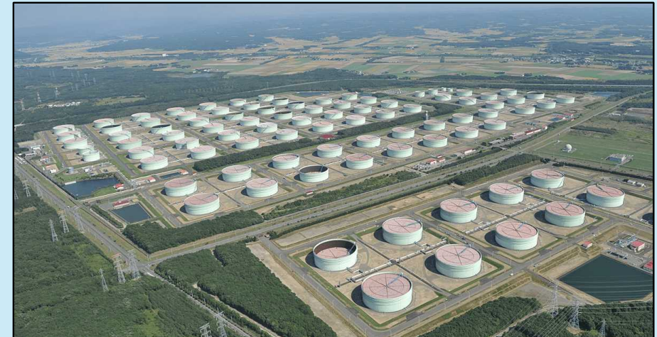
苫小牧国家石油備蓄基地（北海道）
