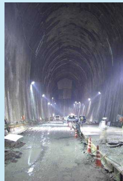
倉敷基地地下貯槽の様子 (建設時) ※ 2
