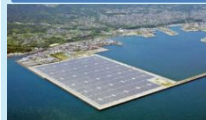
太陽光発電所
