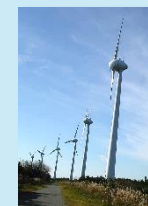
例：風力発電設備の工事計画の審査体制の見直し
