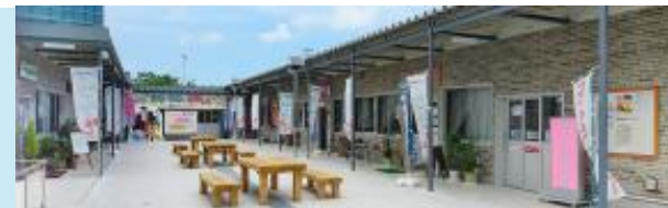
中小機構が設置した仮設施設
