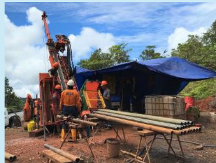
海外における地質構造の把握のためのボーリング調査
