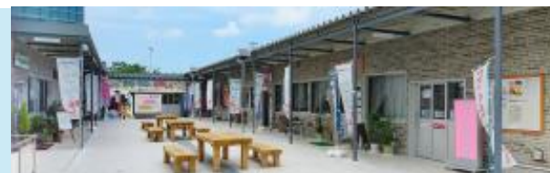
中小機構が設置した仮設施設
