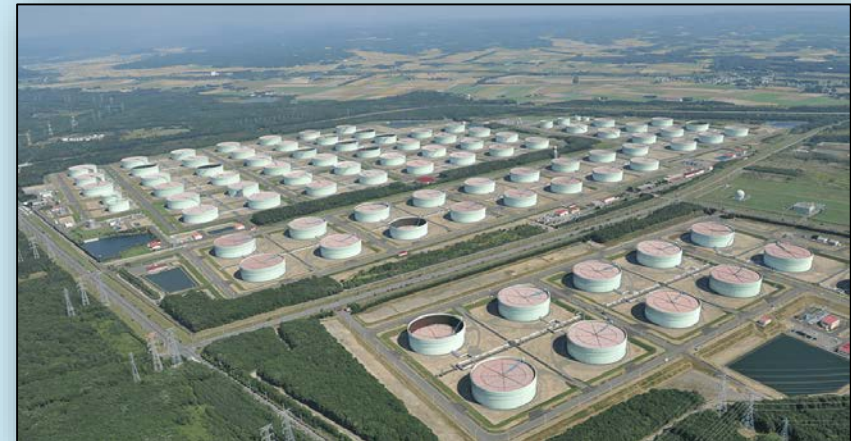
苫小牧国家石油備蓄基地（北海道）
