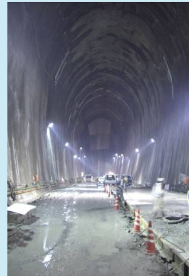
倉敷基地地下貯槽の様子 (建設時) ※2
