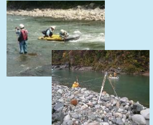
流量調査・測量作業
