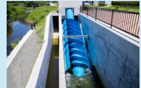
低落差でも安定して発電可能な水車の開発事例
