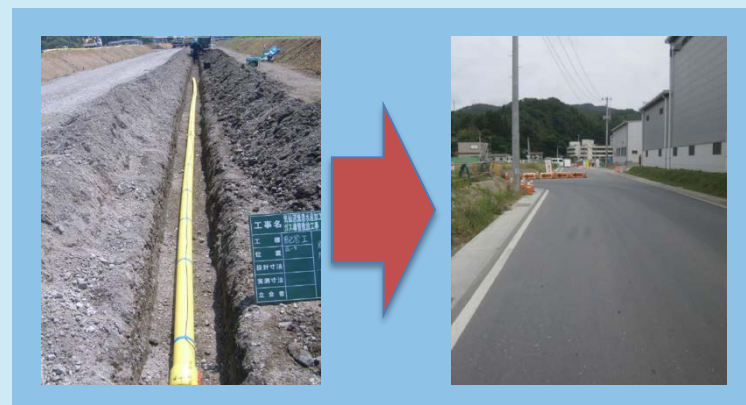
ガス導管再敷設工事の様子（気仙沼市）
