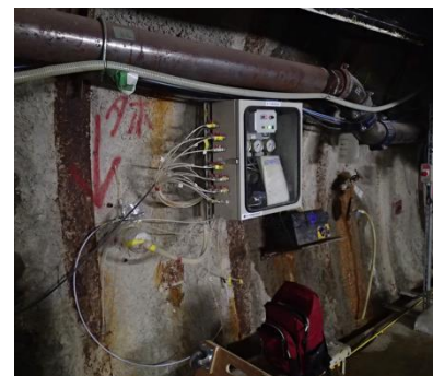
分析用地下水の採水作業
