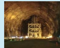
波方基地 (上：地上設備、 下：地下岩盤貯槽)
