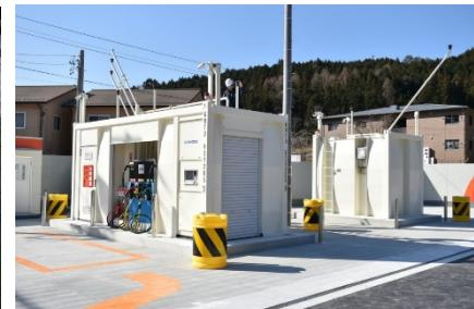
過疎地等におけるローコストかつ短期間で設置可能なコンテナ式給油所(地上タンク)の実証
