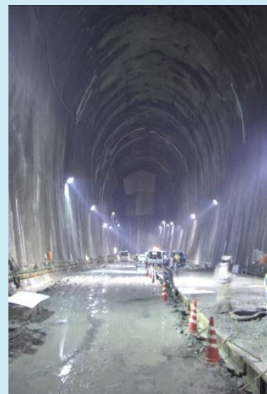
倉敷基地地下貯槽の様子 (建設時) ※2
