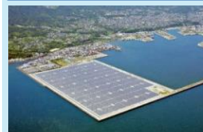
太陽光発電所
