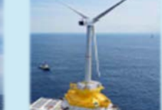
5MWダウンウインド風車搭載 アドバンススーパー浮体 「ふくしま浜風」
