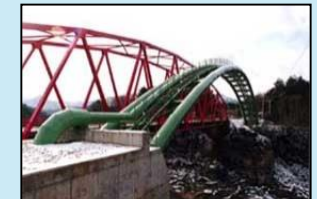
パイプライン
