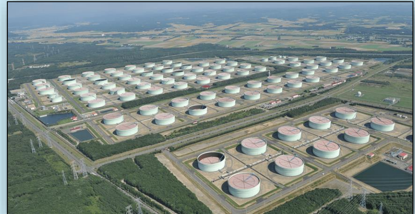
苫小牧国家石油備蓄基地（北海道）
