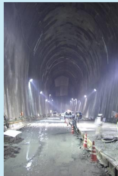
倉敷基地地下貯槽の様子 (建設時) ※2
