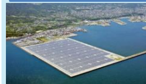
太陽光発電所
