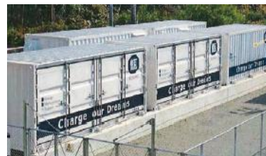
定置用蓄電システム例
